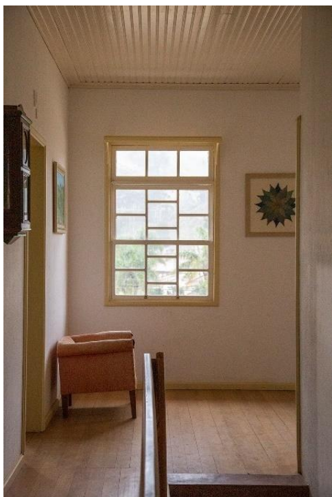
Fig. 22: Vista interna de janela tipo guilhotina com esquadria de madeira e vidro. Antigo Hotel Schütz, Taquaras. (Foto de agosto de 2023).
