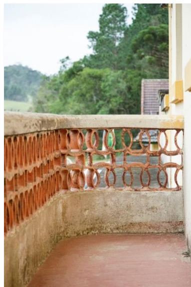
Fig. 17: Sacada com guarda-corpo de alvenaria, decorado internamente com cobogó cerâmico. Antigo Hotel Schütz, Taquaras. (Foto de outubro de 2023).
