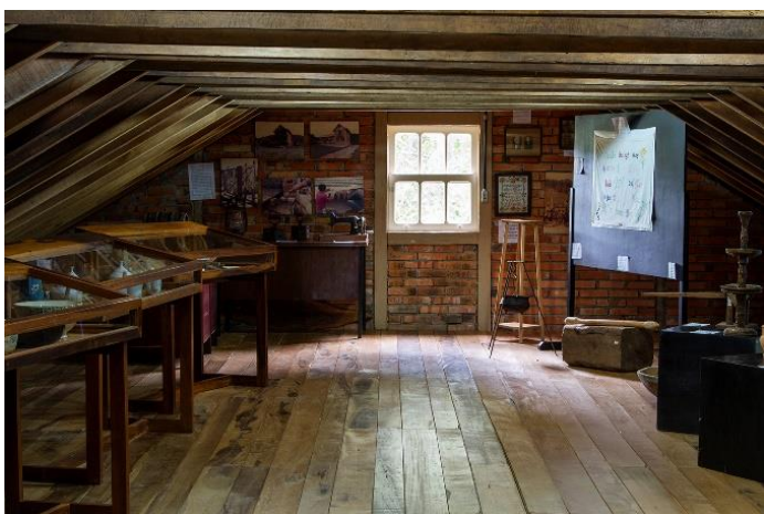
Fig. 10: Sótão com vigas em madeira, chão de tábuas e parede de tijolos aparentes. Casa de Campo do Governador Hercílio Luz, Taquaras. (Foto de novembro de 2012).
