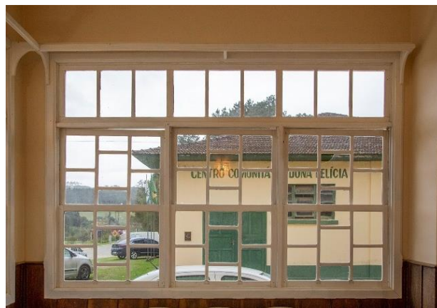
Fig. 21: Vista interna de janela panorâmica com esquadria de madeira e vidro. Antigo Hotel Schütz, Taquaras. (Foto de agosto de 2023).
