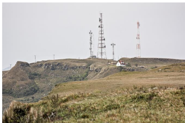
Fig. 125: Antenas de telecomunicações instaladas no topo da Serra. (Foto de setembro de 2010).
