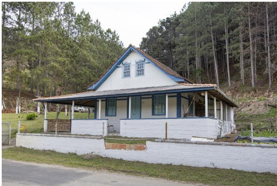
Fig. 92: Antiga casa de alvenaria com vários quartos que serviram de pouso para os tropeiros. (Foto de outubro de 2023).
