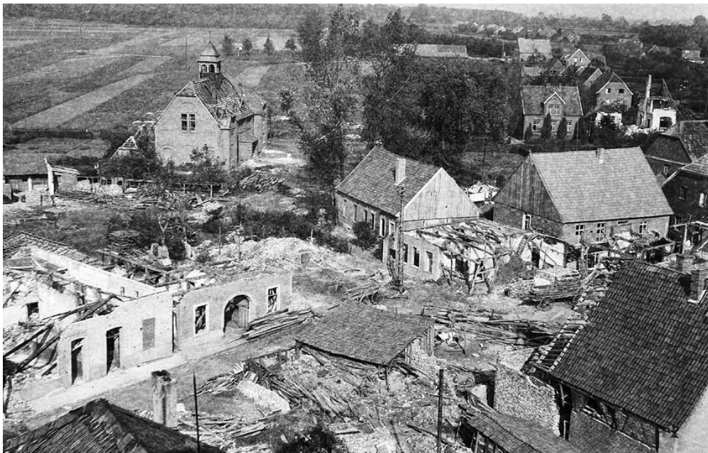
Fig. 18: Centro de Südlohn parcialmente destruído após três bombardeios em 22.03.1945. (Acervo da Associação Histórica de Südlohn, Alemanha).
