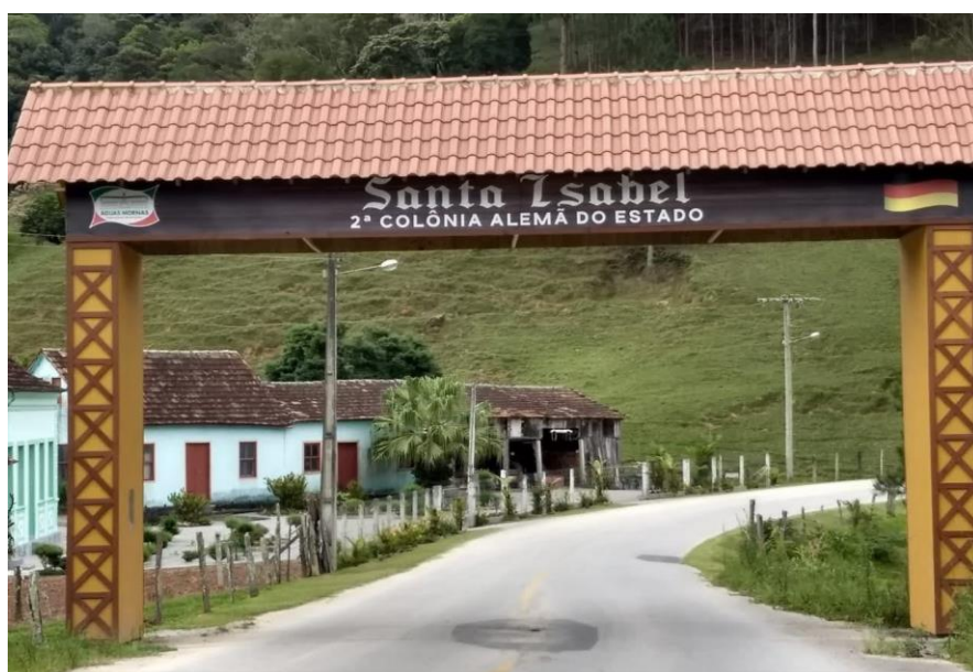
Fig. 17: Pórtico de acesso à localidade de Santa Isabel, em Águas Mornas/SC, 2021. (Acervo da autora).
