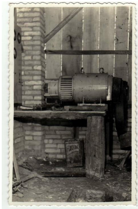
Fig. 5: Gerador de energia elétrica registrado por Frei Raul Bunn, durante a construção do Complexo de Benfeitorias, na localidade de Loeffelscheidt. 1973 (acervo da Igreja Nossa Senhora da Glória).
