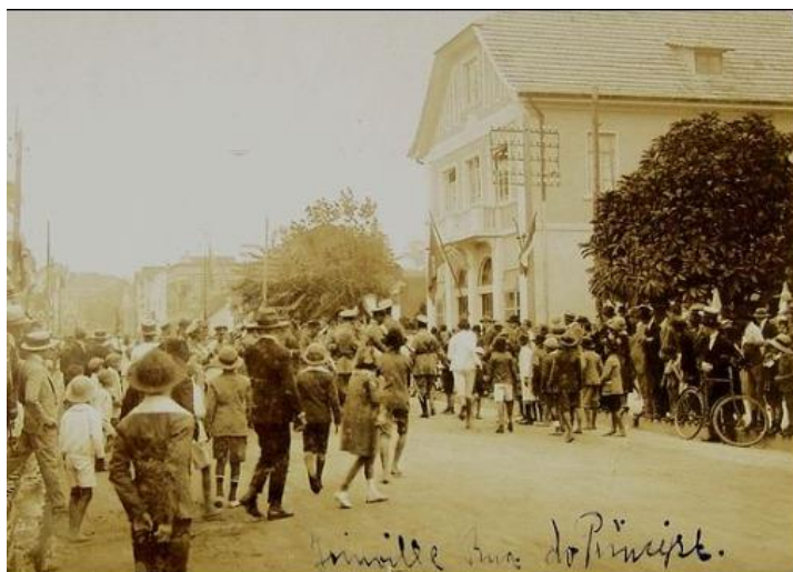
Fig. 6: O prédio à direita: Escola de datilografia Remington Official na Rua do Príncipe, em 1926. Acervo Histórico de Joinville.
