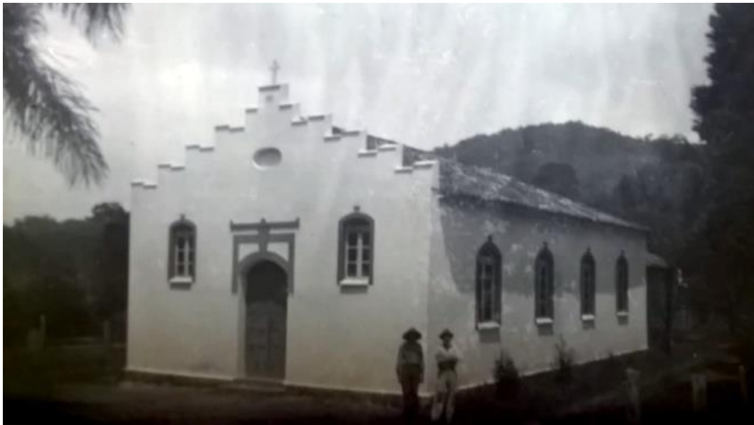
Fig. 8: Primeiro templo da IECLB da comunidade de Rio Sete construído em 1918 e inaugurado no dia 19 de janeiro de 1919. Na foto, August Wenz (ajudante) e Teodoro Wasielewski (construtor). Acervo: Manfredo Mohr. Esta igreja, que recebeu posteriormente o acréscimo de uma torre, é a mesma que ainda existe e que está em uso atualmente.
